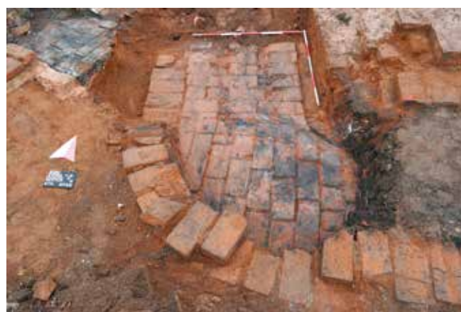
Obr. 11: Ohyb kanálu (teplovzdušného či kouřového) s plochým, cihlami dlážděným dnem. Některé cihly se značkou AH z cihelny Antonína Hergeta. Foto T. Blažková, Labrys, o.p.s., 2014
