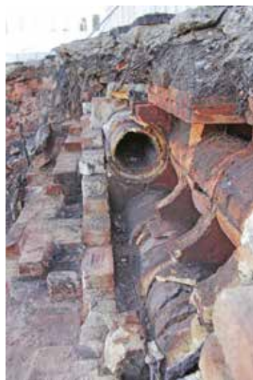
Obr. 14: Detail vnitřního zařízení pece v jižním celkovém profilu zkoumané plochy s trubkami a šamotovými cihlami s označením i speciálním tvarem, kotvicí vnitřní konstrukční prvky. Foto T. Blažková, Labrys, o.p.s., 2013
