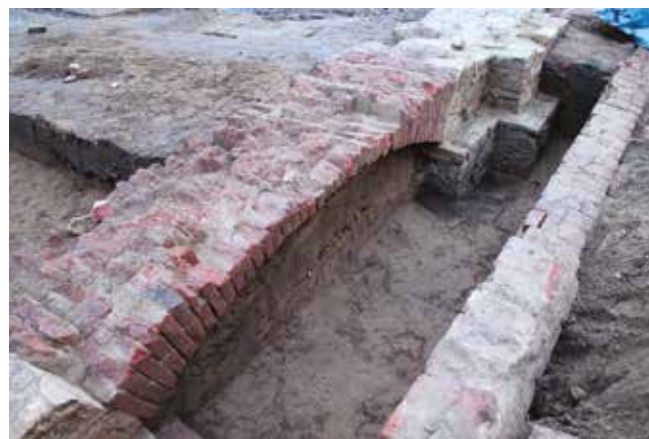
Obr. 10: Opuková patka s předzákladem a cihlový vynášecí pas v sondě č. 37. Foto T. Blažková, Labrys, o.p.s., 2014
