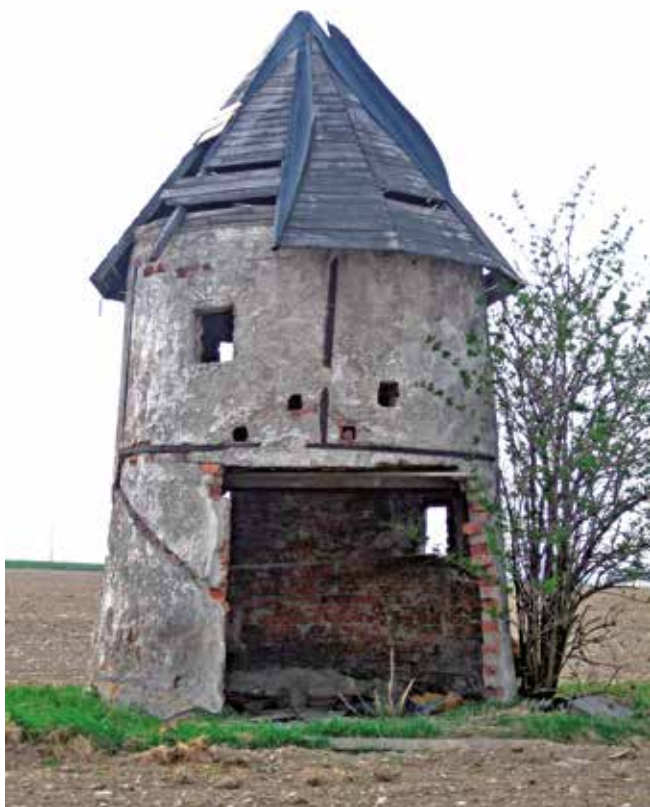
Obr. 5: Spálov před rekonstrukcí
