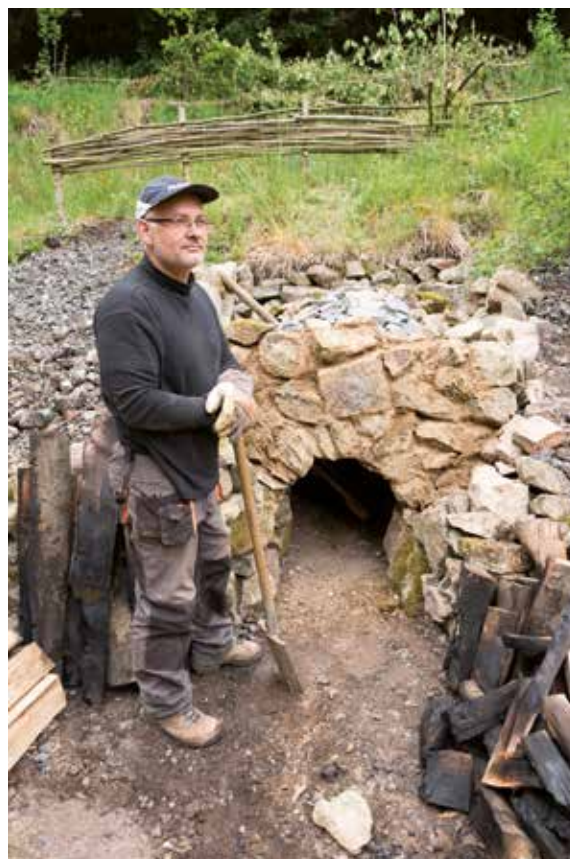
Obr. 4: Petr Kos u jednokomorové „selské“ vápenné pece. Pec je zaplněná vsázkou a připravená k zapálení. Foto Martin Barák 2015
