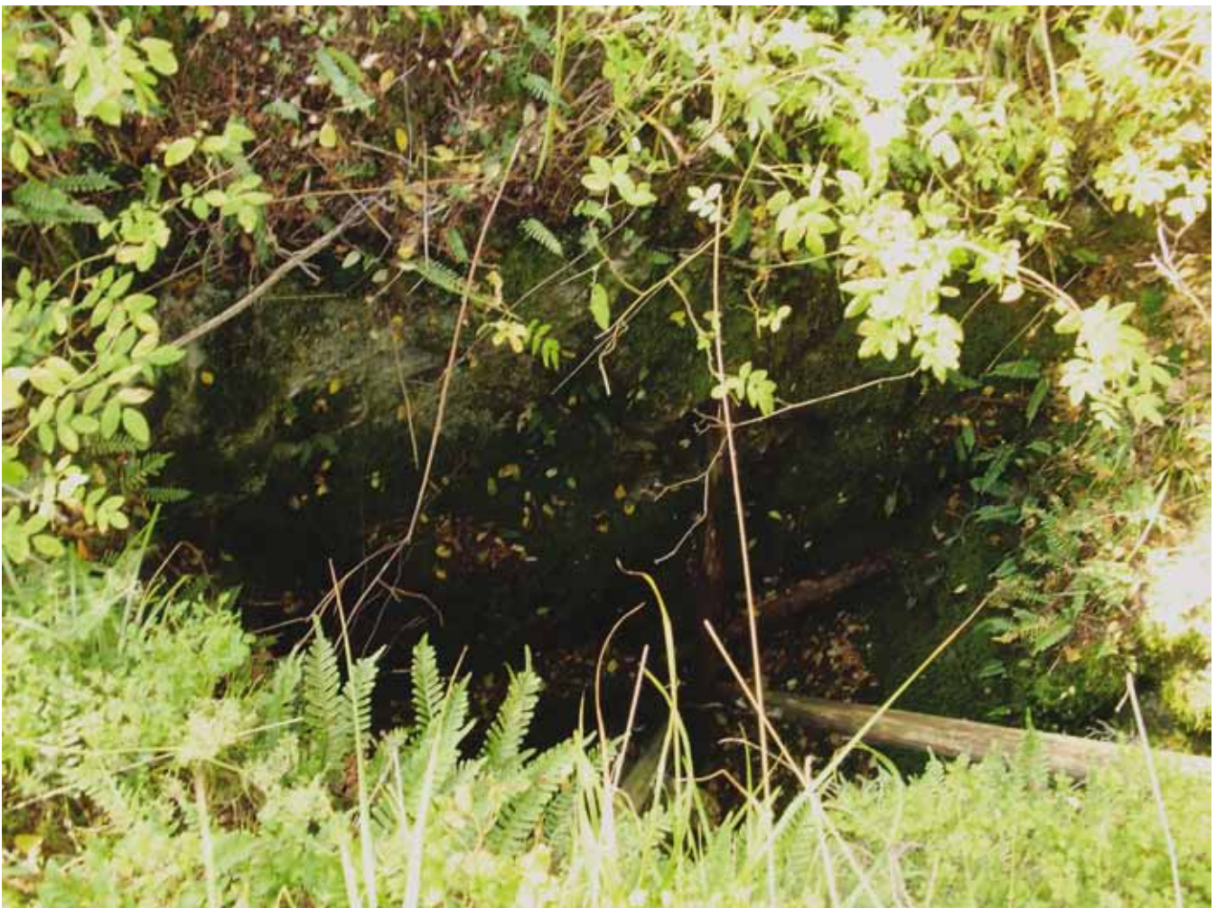
Obr. 1: Spišské Bystré – Kopytárová, zaniknutá šachta (poloha č. 2 v mape 2). Foto P. Roth
