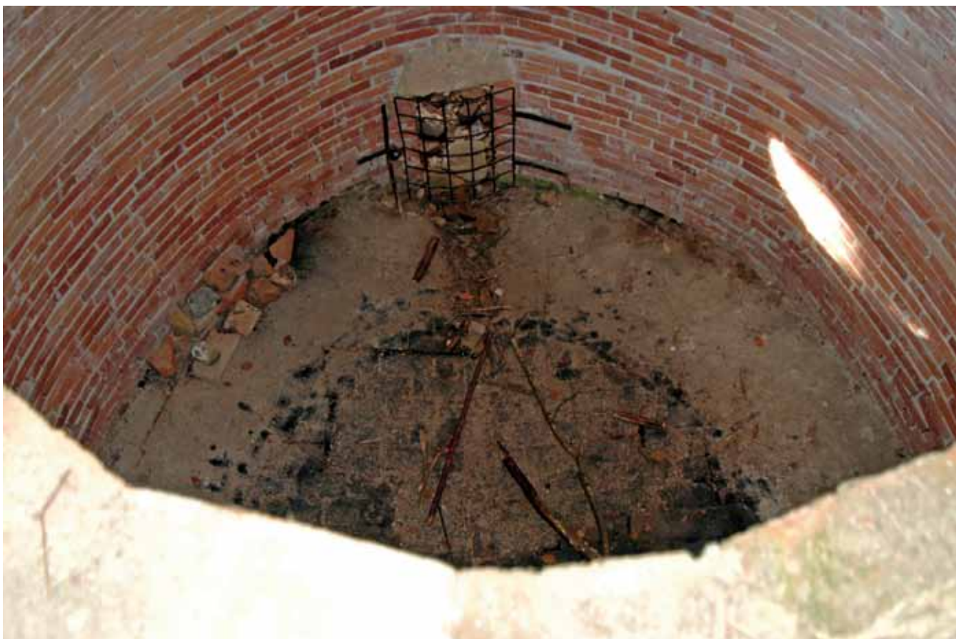
Obr. 6: Pohled do částečně rekonstruovaného vnitřního prostoru kolomazné pece, zachován je pouze vnější plášť, vnitřní rozkladná komora se nedochovala, nápadné je pouze propálení a prosmolení jejího dna. Plzeň-Bolevec, Česká republika. Foto J. Woitsch, 2005
