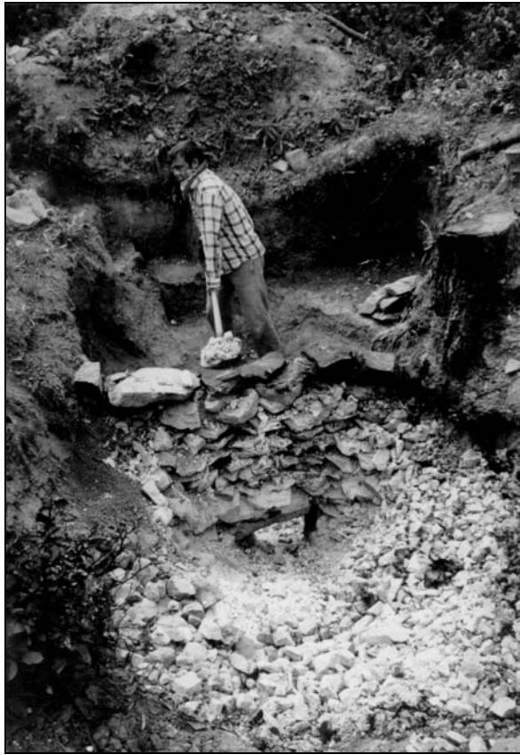
Foto 3 Mokrá (okr. Brno-venkov), Spálená seč. Pracovní snímek zachycující vybírání vápna z pece
