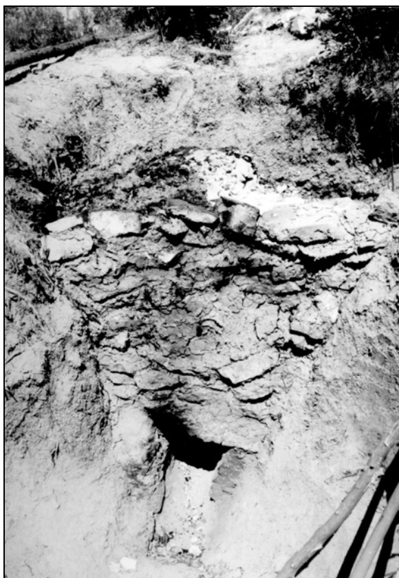
Foto 2 Mokrá (okr. Brno-venkov), Spálená seč. Pohled na čelní zděnou plentu pece těsně po ukončení provozu
