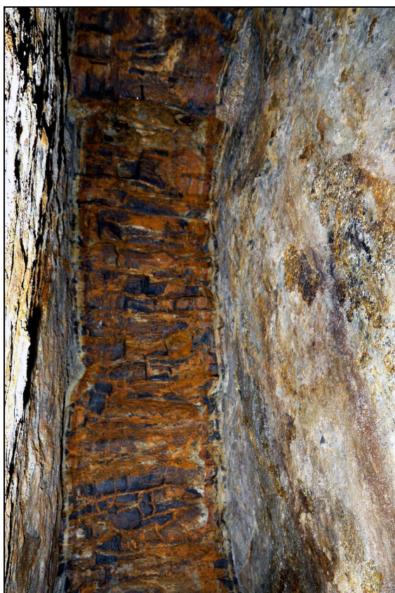
Obr. 5 Kryt u Textilany – rozpadlá čedičová výplň pukliny tloušťky 700 mm
