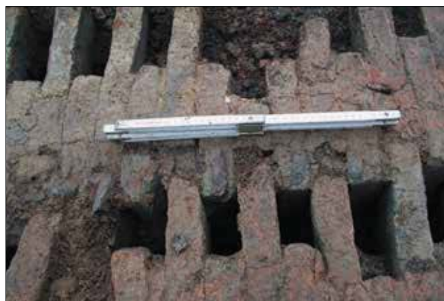
Obr. 14: Zbytky přilepených střešních tašek na vypalovacím roštu pece
