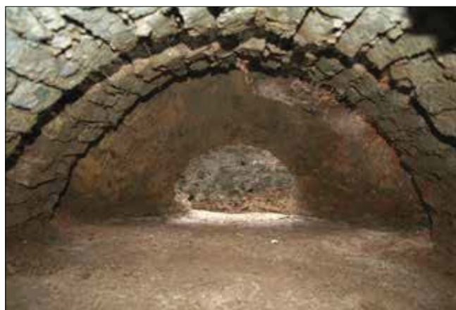
Obr. 12: Detailní pohled do dolní části vypalovací komory pece. Pohled směrem do prostoru předpeční jámy
