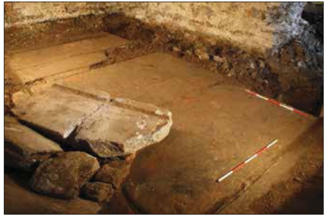
Obr. 4: Dno náduvníku v panském pivovaru ve Žďáře nad Sázavou vyskládané z kamenných desek
