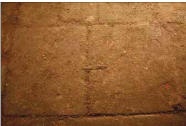
Obr. 5: Detail spoje kamenných desek ve dně náduvníku železnou sponou
