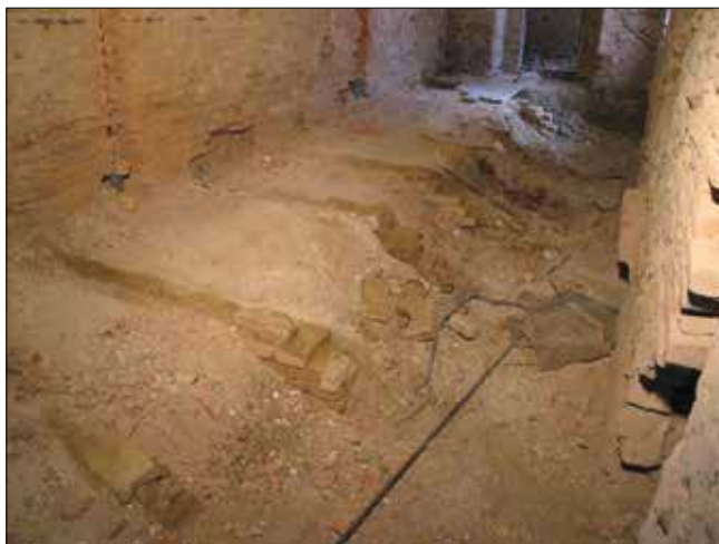
Obr. 10: Studené tahy dvojlískového hvozdu v pivovaru/sladovně v Králově Poli
