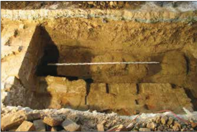
Obr. 3: Základové zdivo pro založení náduvníku v klášterním královopolském pivovaru
