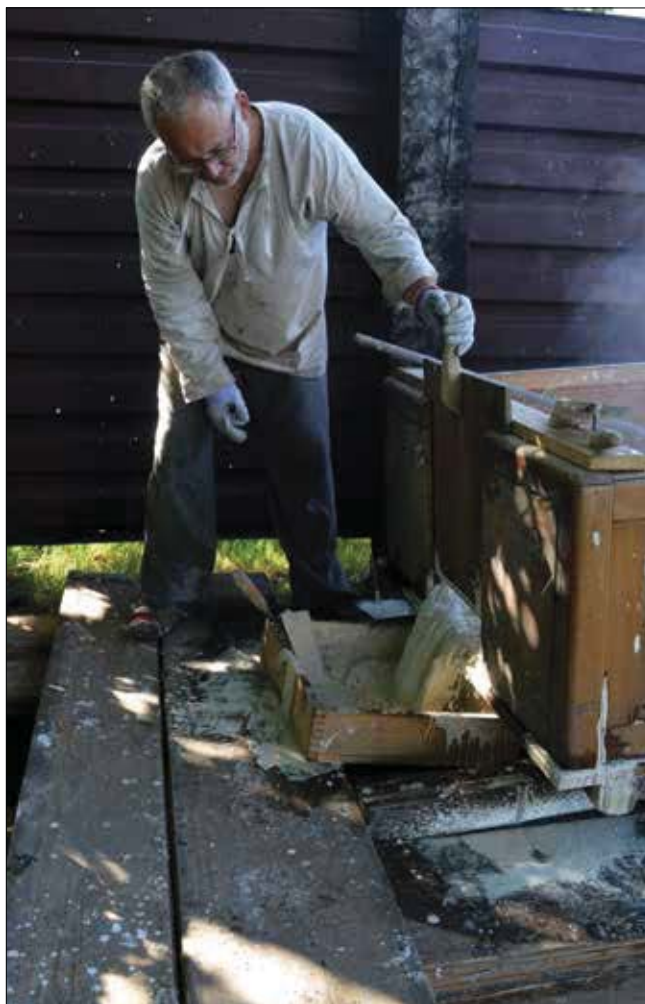
Obr. 3: Kostelec nad Černými lesy, září 2018. Hašení vápna z hasnice do jámy (foto Petr Holub)
