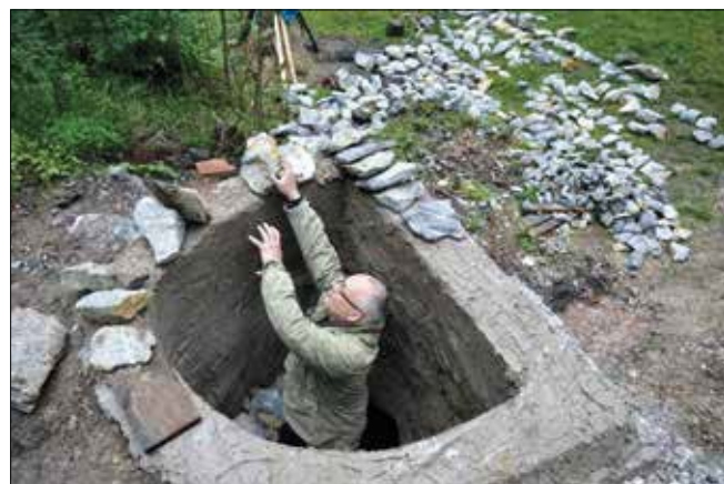
Obr. 2: Stará huť u Adamova. Zakládka vápencové klenby (foto P. Holub)
